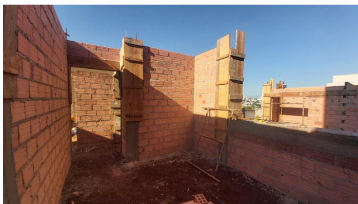
Figura 4 – execução vergas de abertura obra rua Vicente Machado
