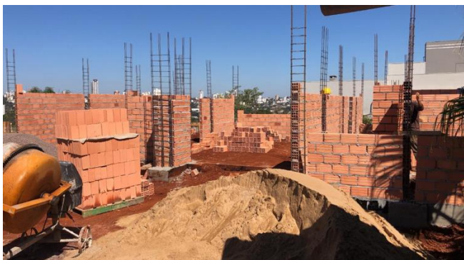
Figura 2 – Assentamento de tijolos obra rua Vicente Machado
