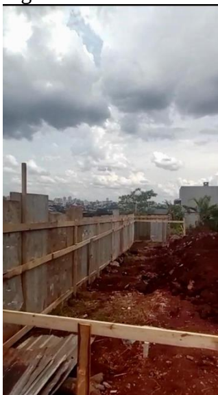
Figura 1 – Aterro obra rua Vicente Machado
