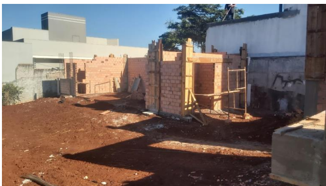
Figura 3 – execução de pilares obra rua Vicente Machado
